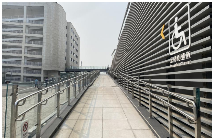
室外无障碍坡道（二）
