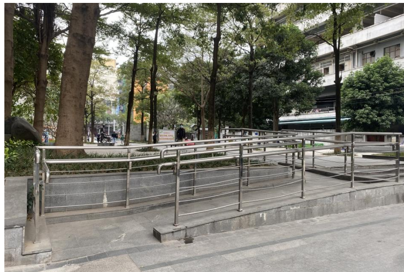
室外无障碍坡道（一）
