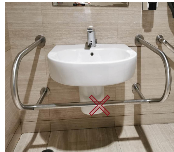
无障碍洗手盆扶手横杆设置过低
