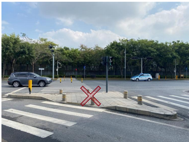
安全岛坡度大于1:10轮椅无法自主停留
