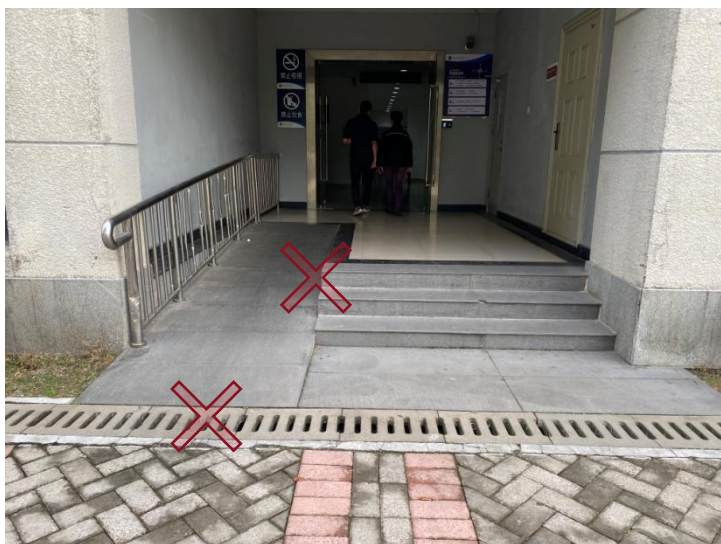
轮椅坡道未设置两侧扶手、匏子方向错误
